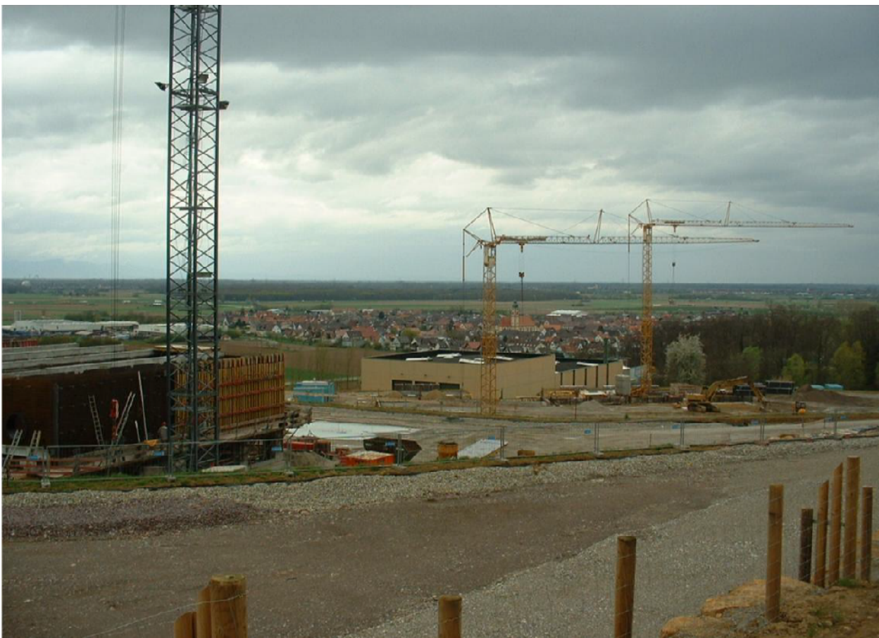
Abbildung 11 Bau der Perkolatoren (links) und Geländeprofilierung, Februar 2005
