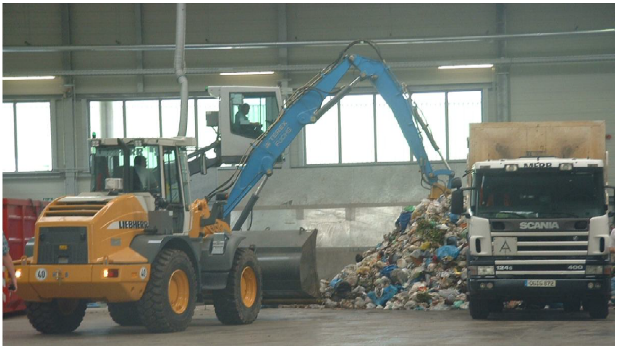
Abbildung 3 Abfalleintrag im Anlieferbereich
